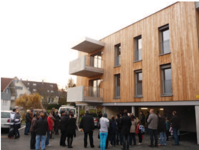
Reges Interesse bei der Schlüsselübergabe an die Mieter der neuen VOGEWOSI Passivwohnanlage beim Lehrerhof.
