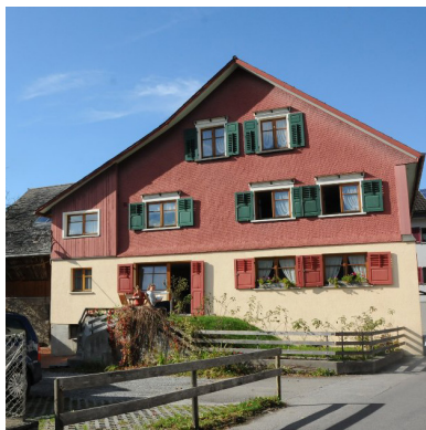
Haus Büttels 6 - Südostansicht
