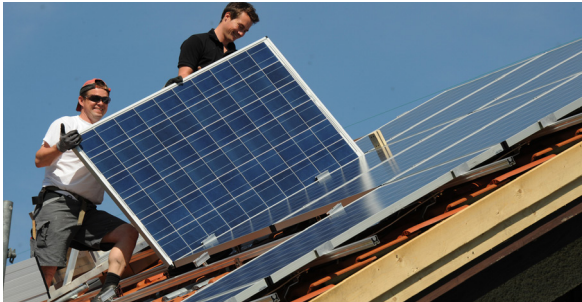
Montage einer Photovoltaikanlage.
